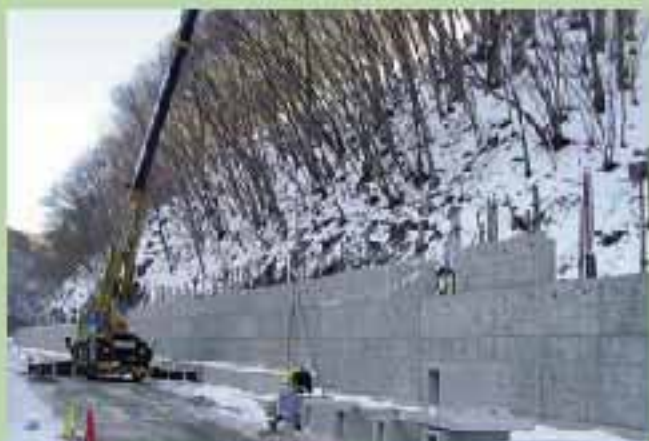
12. ブロック積上げ (C1・2ブロック)
