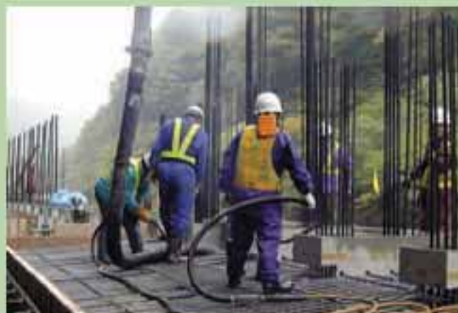
8. 底版コンクリート打設
