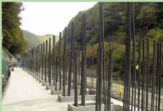
9. 底版コンクリート完成
