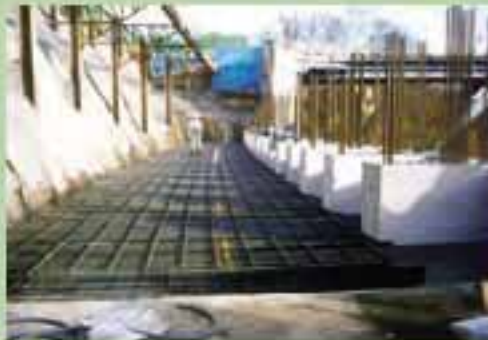
フーチング部配筋
