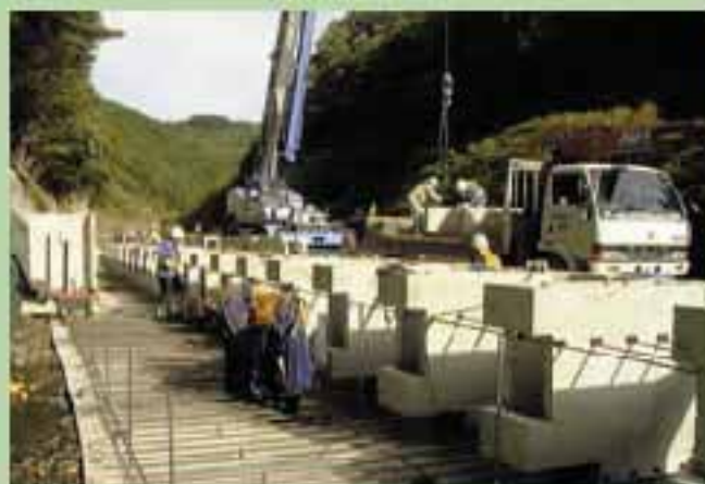
6. 底版鉄筋組立
