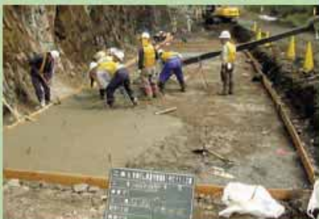
2. 均しコンクリート打設
