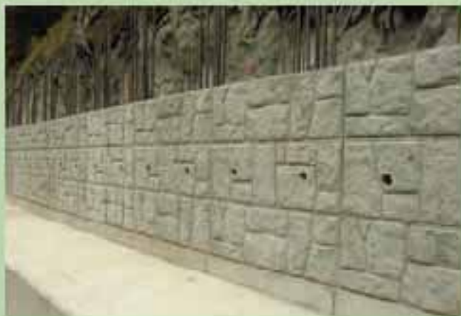
11. ブロック積上げ全景 (D2ブロック)
