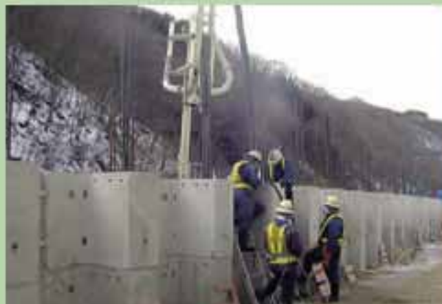
13. ブロック胴込めコンクリート (C1・2ブロック)
