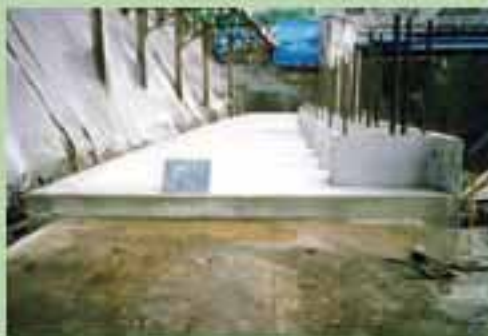
フーチングコンクリート打設
