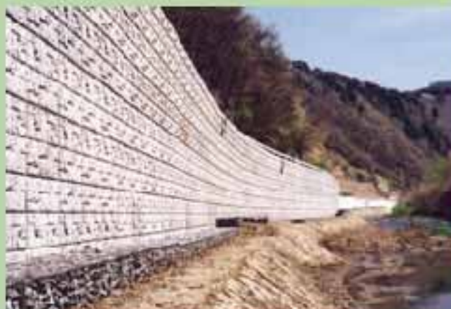
16. ブロック積上げ完成
