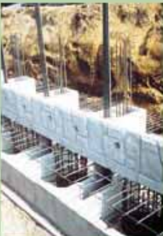
フーチング配筋
