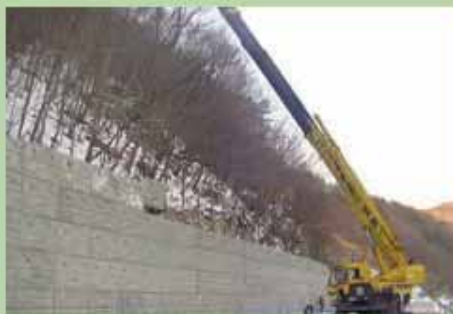
14. ブロック積上げ (NB1・2ブロック)
