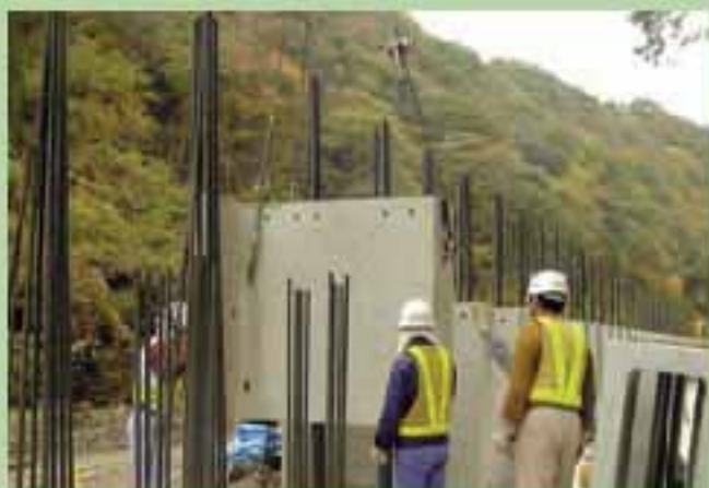
10. ブロック積上げ (D2ブロック)
