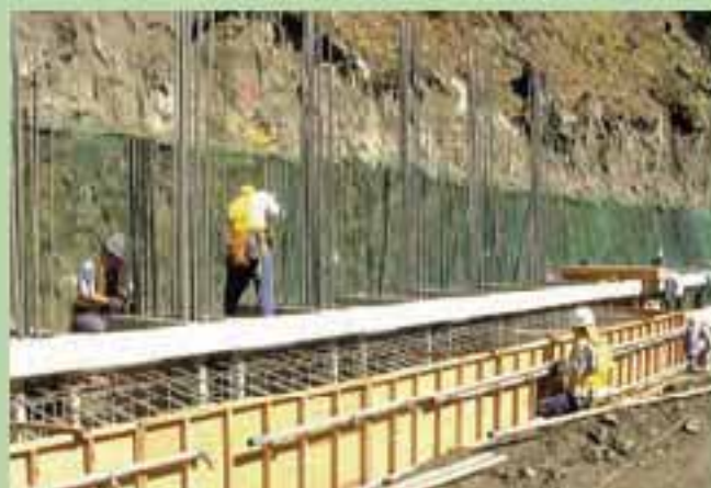
7. 底版型枠組立
