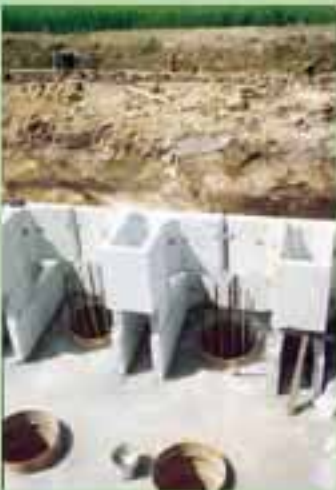
フーチング部杭頭処理
